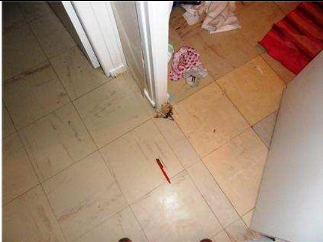
016 - Appartements - Entrée LOT 0101 PH27 : Colles et ragréage amiantés Pas d'amiante dans les dalles de sol PRE027
